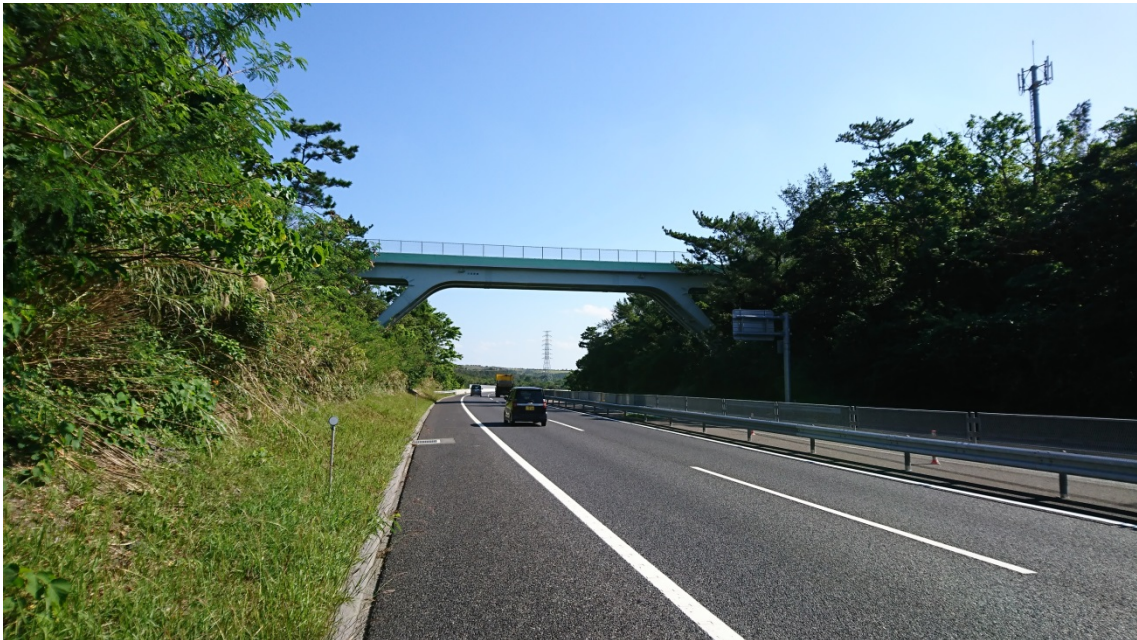
写真：沖縄自動車道に架かる跨道橋「川田原橋」
