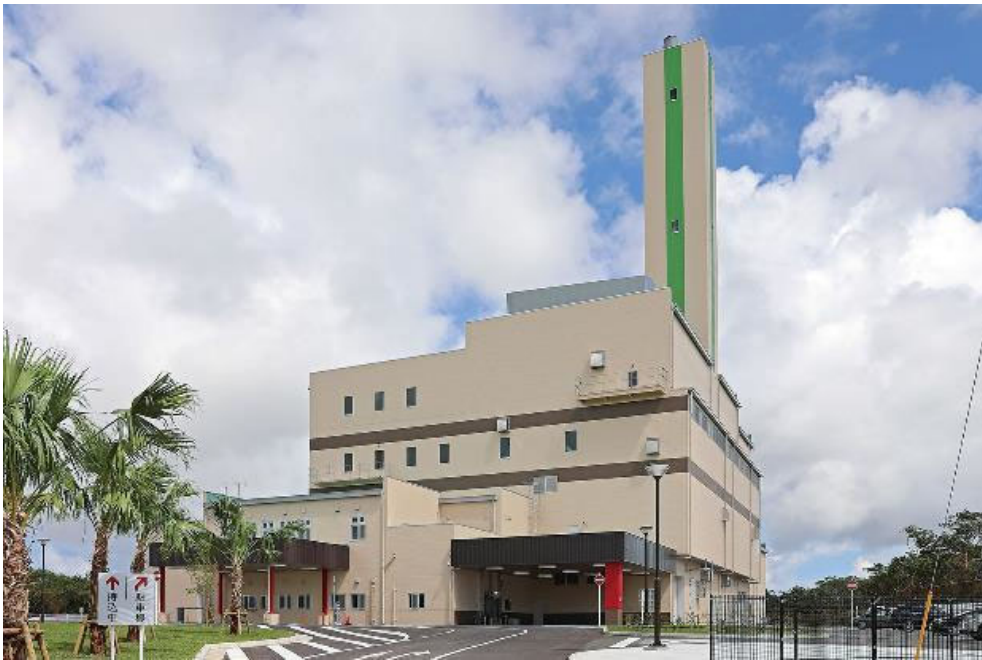
図3.3-1 金武地区清掃センターの外観
