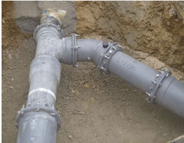
水道管耐震化（配管状況）
