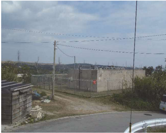
今後更新予定の伊芸地区配水池
