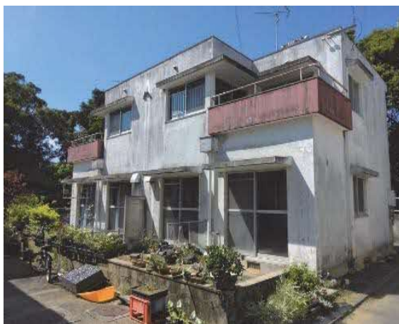
町営住宅中川団地
