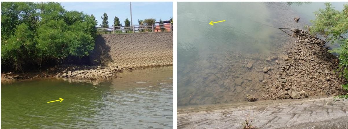
図 1.2.1-4 億首川左岸水制工における土砂堆積状況
