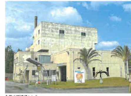
金武地区清掃センター
