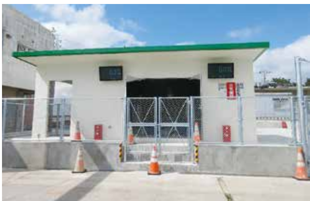
▲改築工事を行った給油施設
