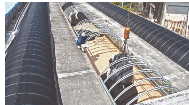
▲3回目の活性炭投入の様子
