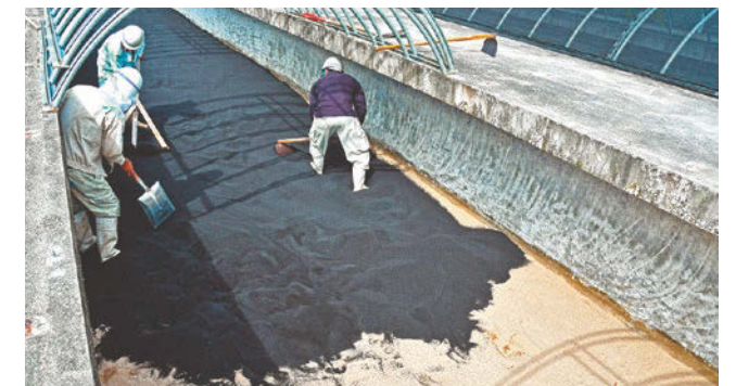
▲砂の上に活性炭を敷設する様子
