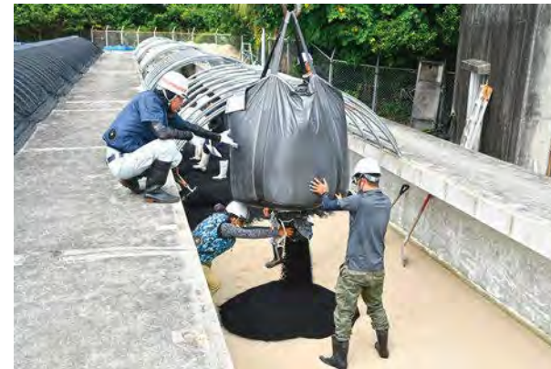
▲活性炭を投入する様子
