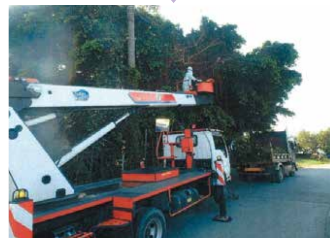
高所作業の様子①
