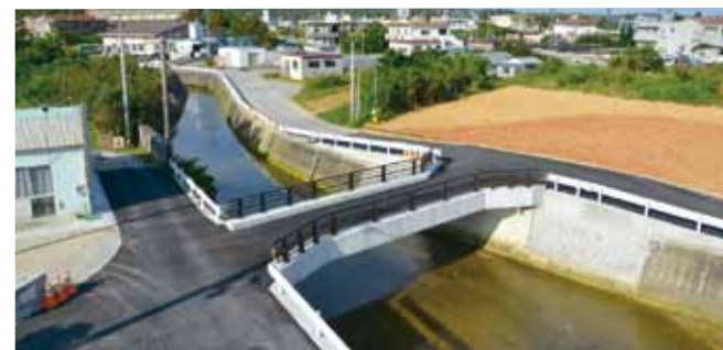
▲屋嘉区、嘉喜(かき)又原(西側)と前田原(東側)を繋ぐ第二前田橋
