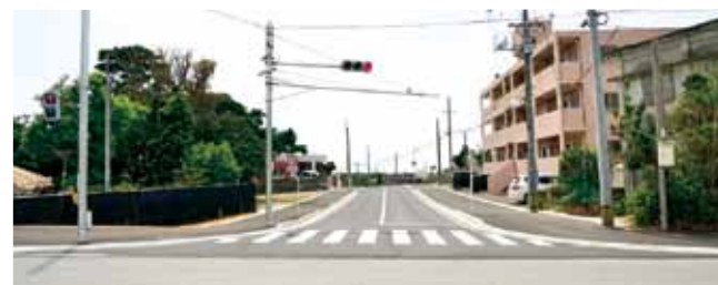
▲国道329号からギンバル地区への入口となる「町道中川30号線」
