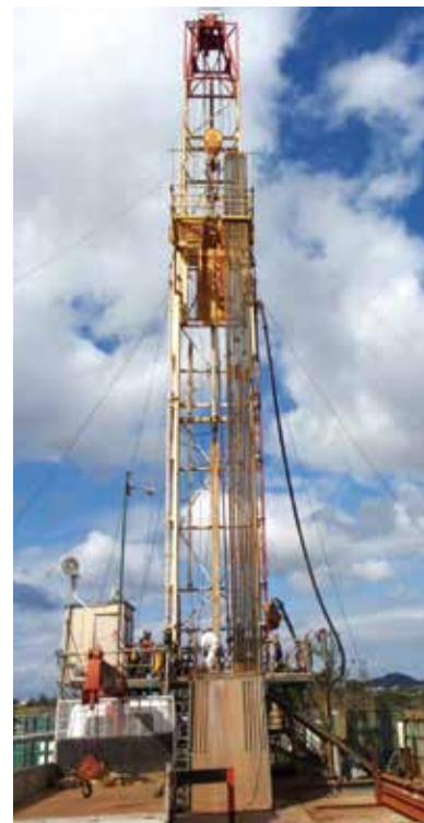
▲掘削作業の様子
