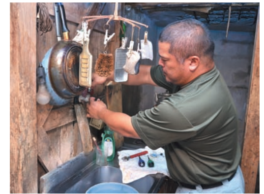
▲ 蛇口の水漏れを修理中
