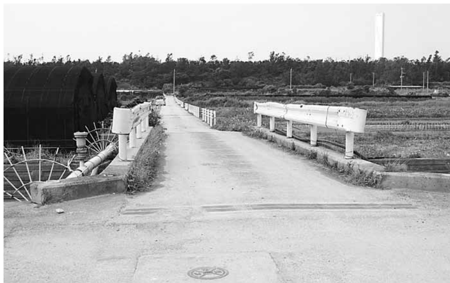
▲架け替え工事が進められる武田原の橋梁
