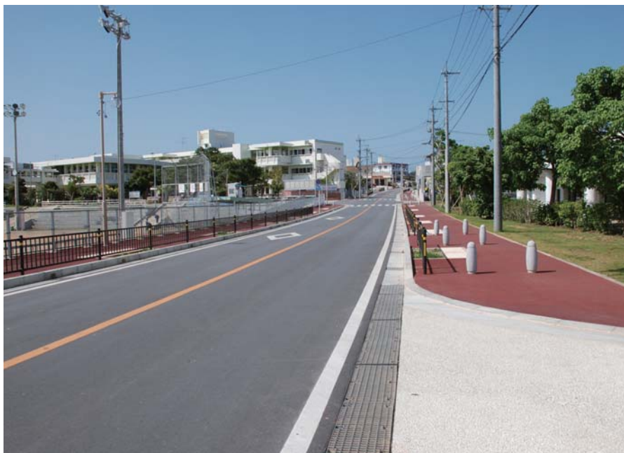
▲整備が進められている町道111号線(中学校付近)
