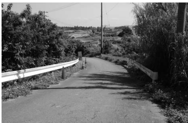
▲道路整備が予定されている町道金武78号线（並里区）
