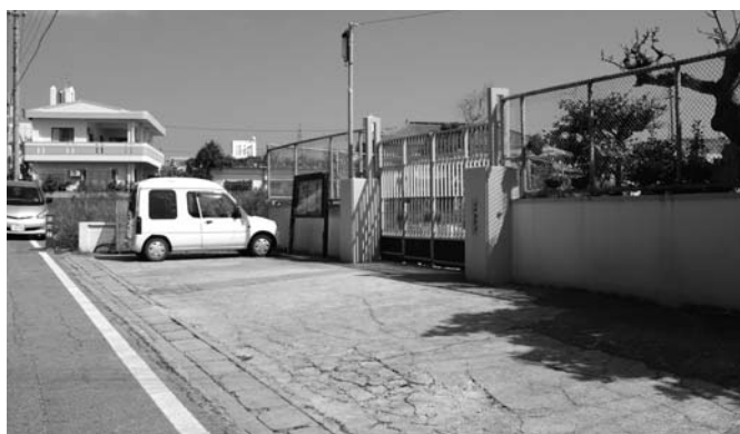
▲園庭拡張と駐車場が整備される予定の浜田保育所
