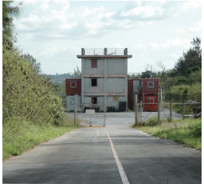
消火訓練施設
