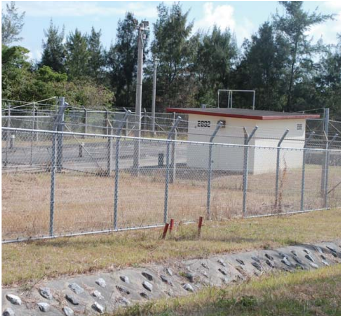
泥土除去施設
