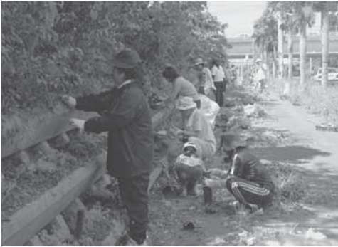
▲国道沿いで作業の様子
