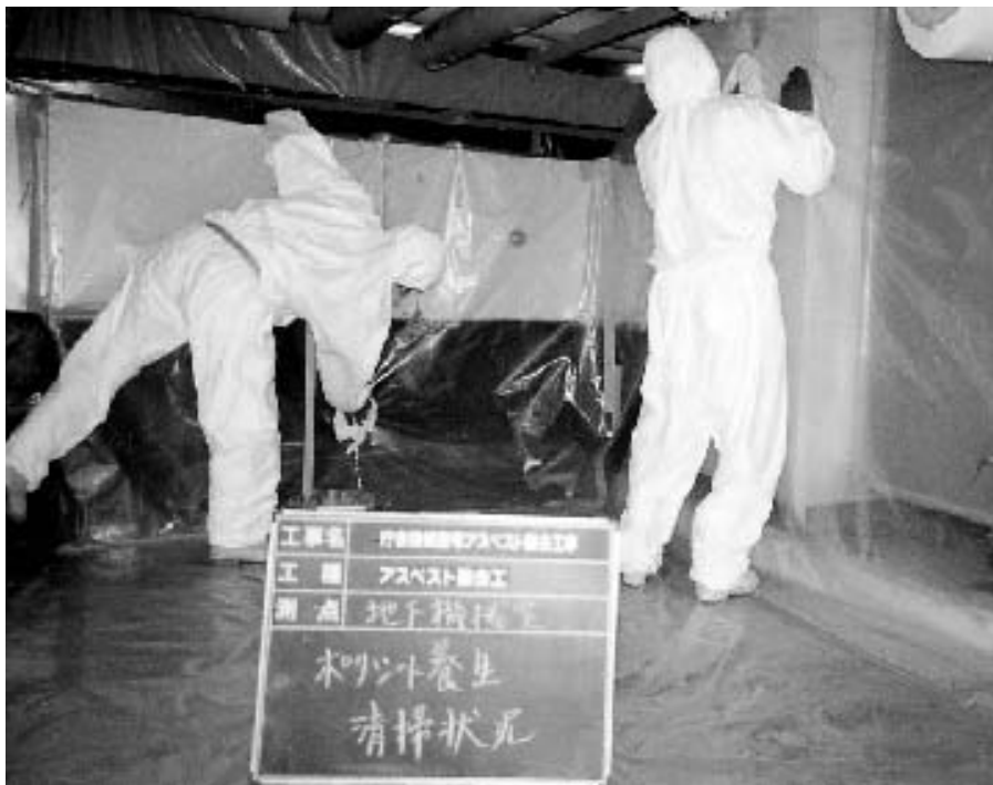
▲金武町役場地下機械室の撤去作業の様子
