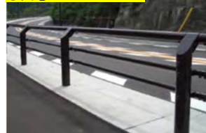
写真③：ガードパイプ-2
