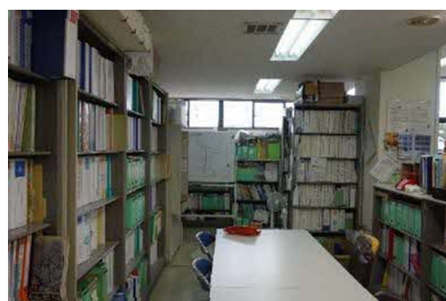
▲耐震処置未対応の収納棚類【本庁舎】
