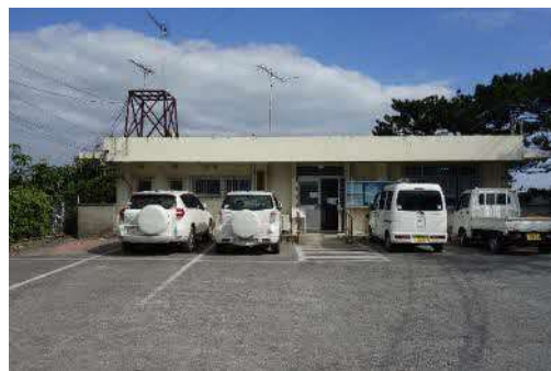
▲上下水道課前の駐車場
