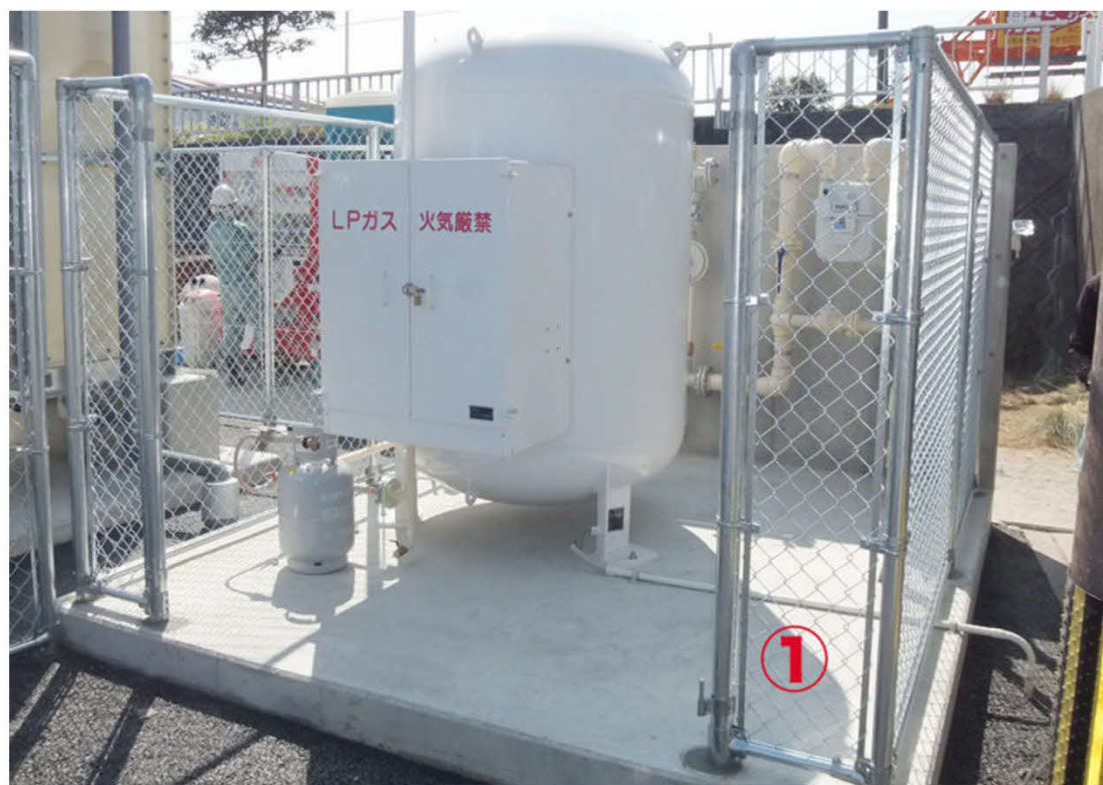
ガスバルク貯槽の設置イメージ
