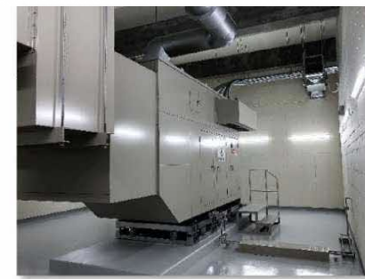
■イメージ写真：非常用発電機設備
