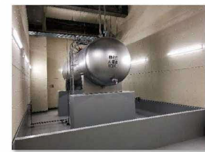
燃料タンク(屋内タンク貯蔵所)
