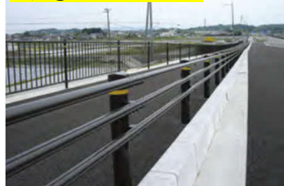
写真②: ガードパイプ-1
