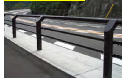
写真③: ガードパイプ-2
