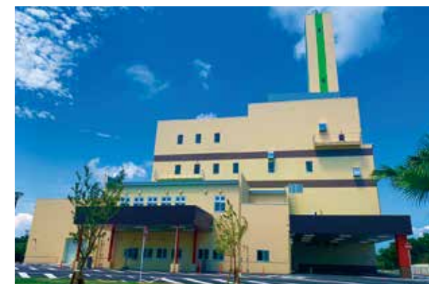
▲金武地区清掃センター
