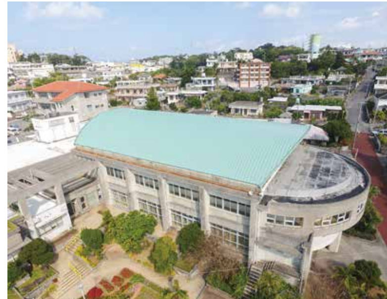
▲完成した並里地区公民館講堂の屋根
