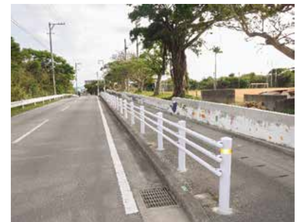
▲改修した防護柵
