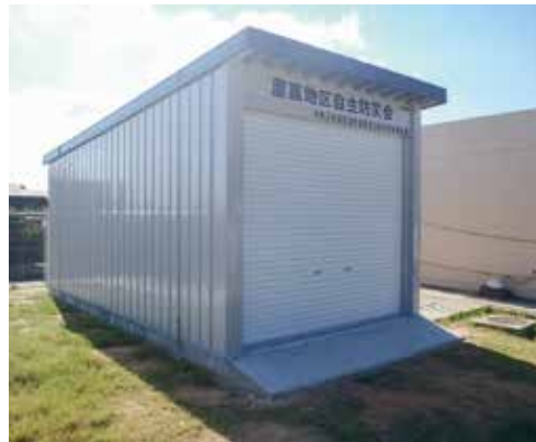
▲防災備蓄倉庫（屋嘉区）
