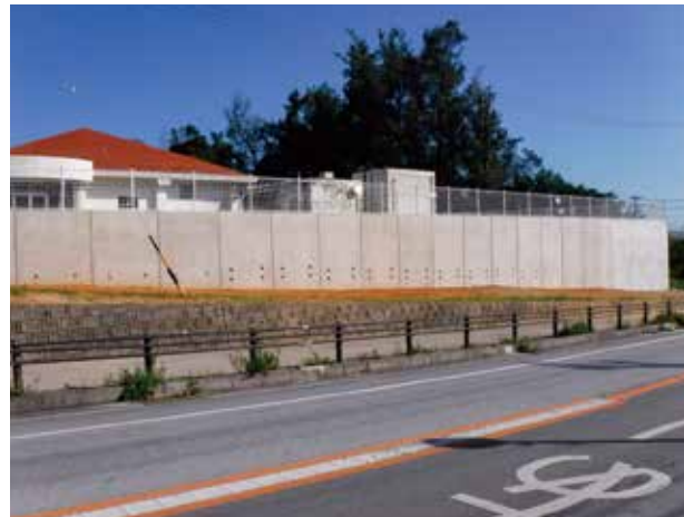
▲完成した嘉芸小学校の擁壁
