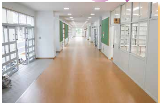
▲廊下【多目的スペース】(中川小学校)
