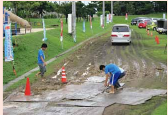
雨の中、駐車場の補修作業
