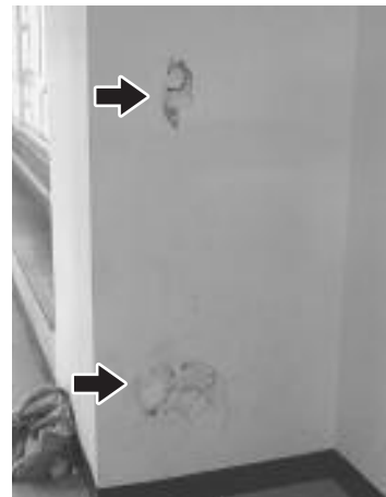
壊された一階エレベータ入り口 横壁二箇所の写真
