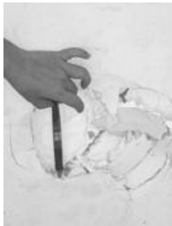
壊された下の箇所の拡大写真
