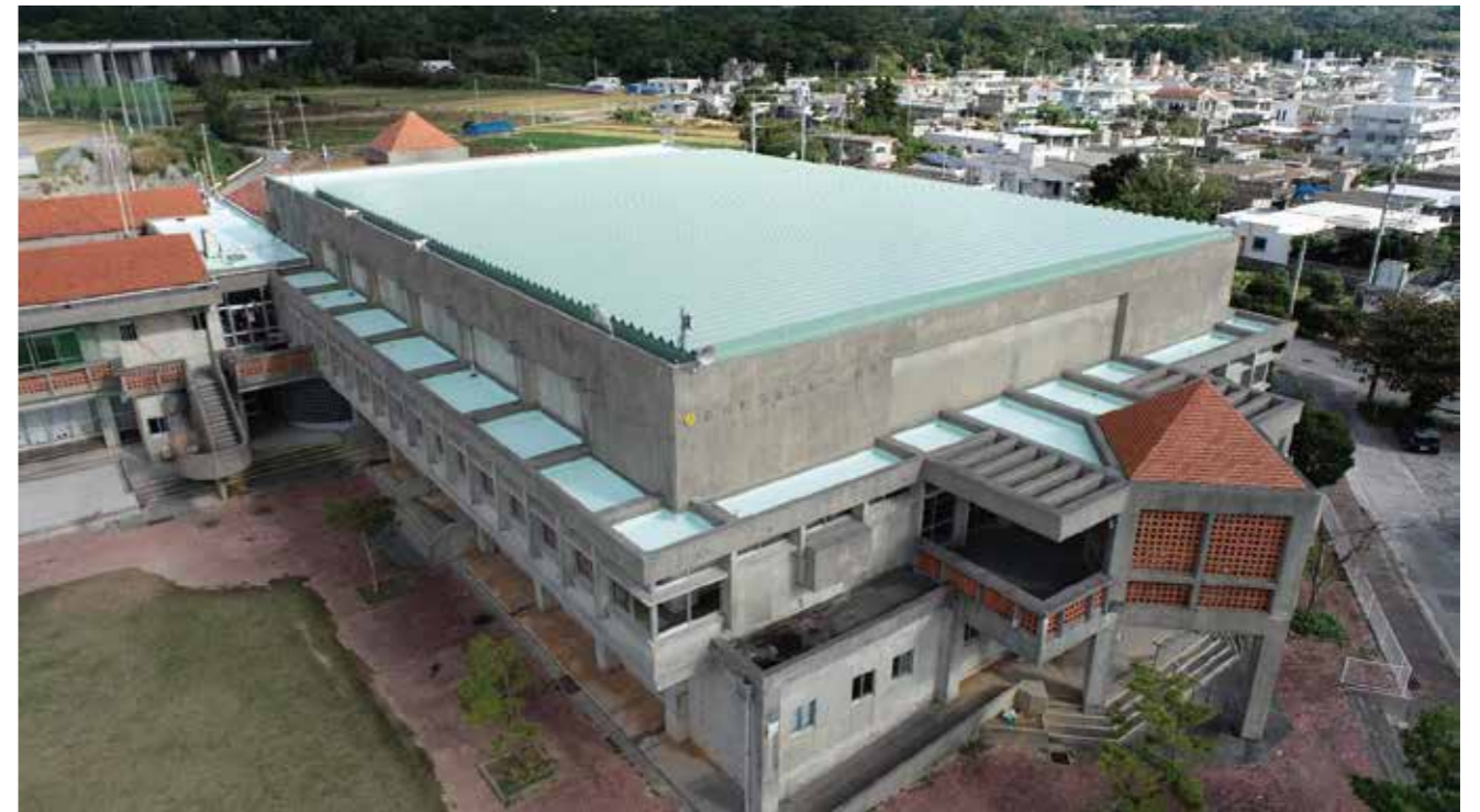
▲改修した屋嘉地区体育館の屋根
