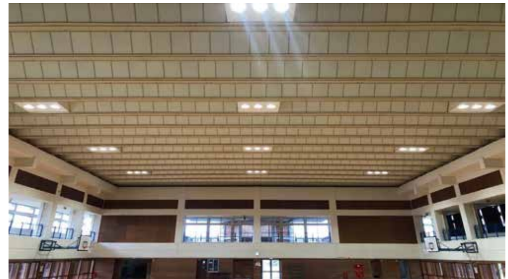
▲改修したLED照明
