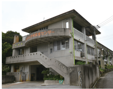
供用開始から26年が経過している給食センター
