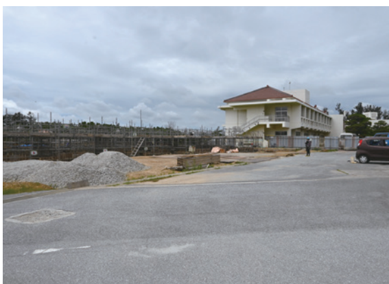
嘉芸小学校屋内運動場建設工事
