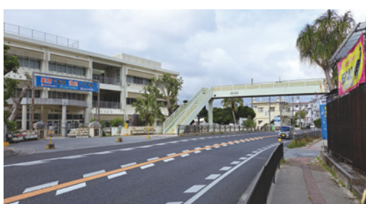
恩納小学校前に設置されている歩道橋 (恩納村)
