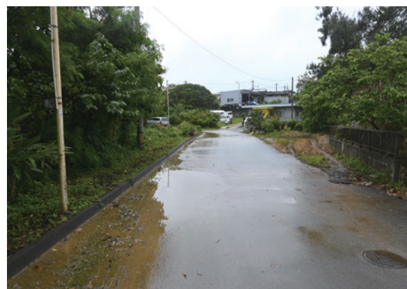
町道金武119号線整備工事
