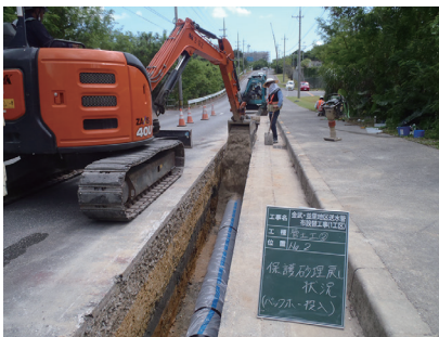
送水管布設工事
