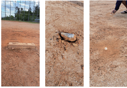
地中の石が露出しているピッチャーマウンド
