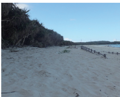
砂が蓄積して歩けない遊歩道
