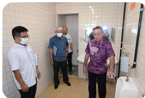
屋嘉区公民館改修工事
