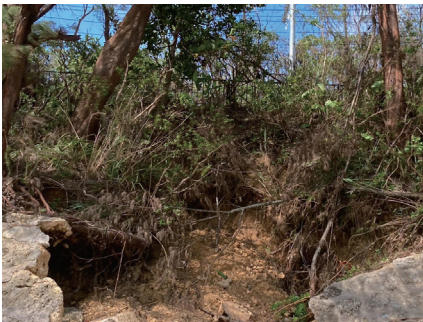
国道329号沿いの護岸
