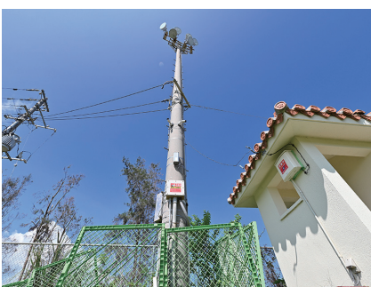
柵で囲まれた照明柱
