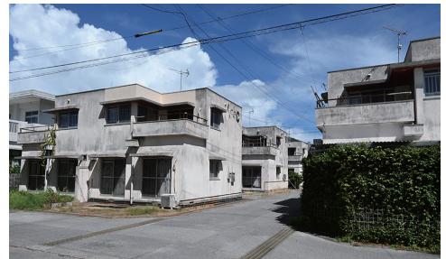
建て替えが計画されている町営住宅屋嘉団地
