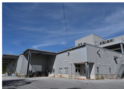
金武町特用林産物（ぶなしめじ）生産出荷施設
