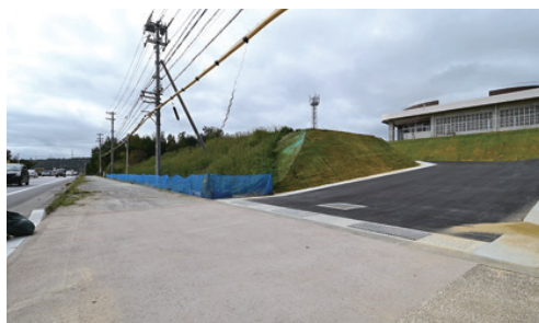
防護柵がない嘉芸こども園前の国道329号
