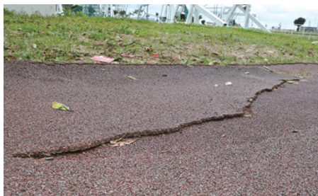
ウレタン舗装が破損しているウォーキングコース
