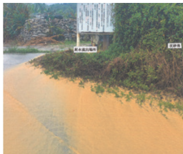
水が溢れ出ている沈砂池
