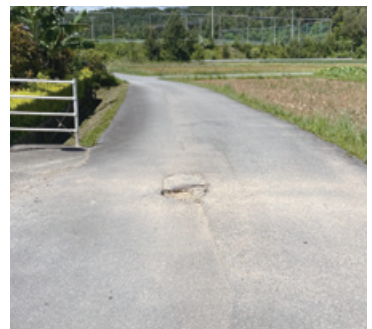
陥没している屋嘉区内の道路
