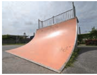
スポーツ広場の スケートボード設備
