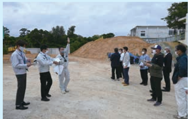
(金武中学校屋内運動場建設工事)
