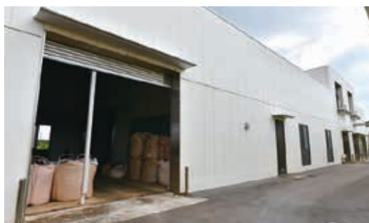
集落排水の汚泥を堆肥化する資源循環施設
