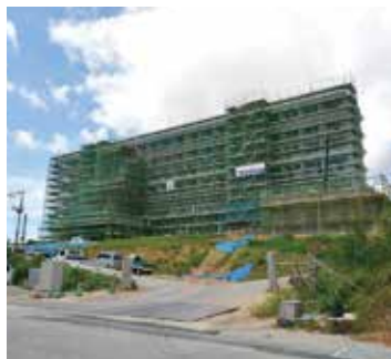
建設中の温泉ホテル
