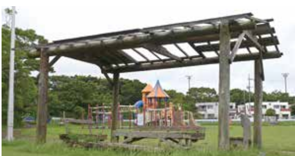
東屋等の改修が計画されている中川地区公園
