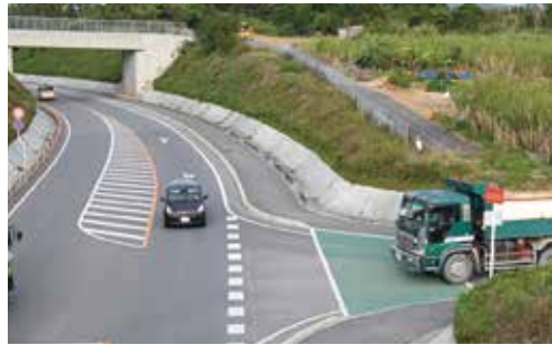
カーブのため中川方面（奥）の見通しが悪いバイパス進入路
