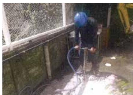
宅内配管工事
