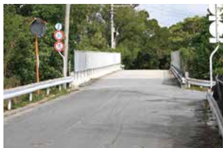
高速道路を横断する橋を境に金武町(奥) と宜野座村(手前)に道路管理者が分かれる
