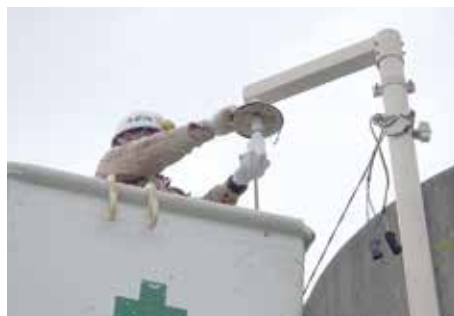
LEDへの改修作業
