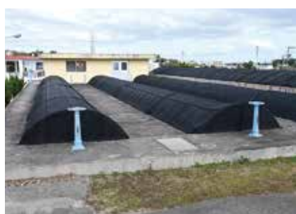
現状は町の浄水場の水と企業局水を混ぜて供給している (写真は並里浄水場)
