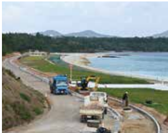
整備が進む町道中川36号線と 海浜公園(ギンバル訓練場跡地)
