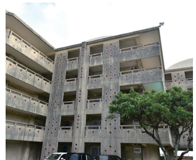
浜田団地の外壁
