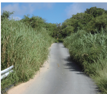
道幅の狭い町道170号線
