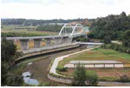
金武大橋付近の国道バイパスの架橋
