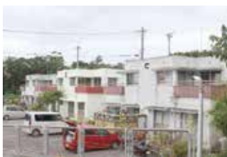
町営住宅中川団地
