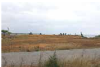
1工区の造成が完了した ホテル建設予定地1工区
