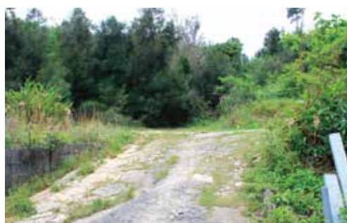
不通となっている避難路
