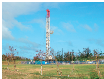
温泉掘削の様子
