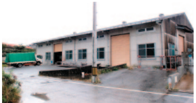
屋嘉地区共同作業施設
