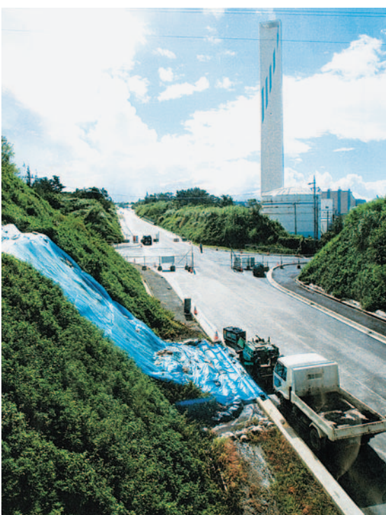
◀ 国道バイパス建設工事 (金武火力発電所付近)
