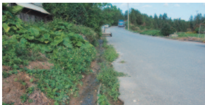
▶側溝が整備されていない地域
