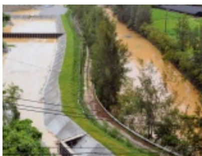
▲大雨によって赤土が流出した状況
