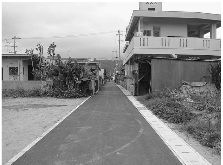
▲住宅より手前が新設部分
