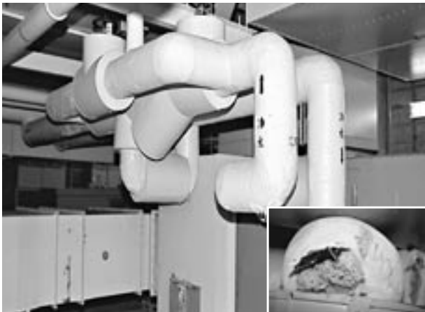
役場3階機械室で発見されたアスベスト
