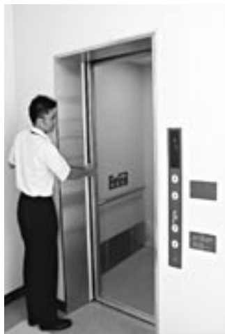
名護市立東江中学校に設置されているエレベーター
