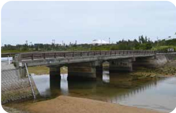
福花橋補修工事
