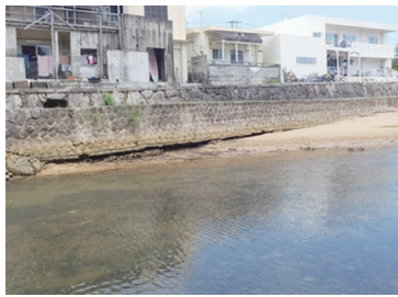
基礎部分が露出している護岸
